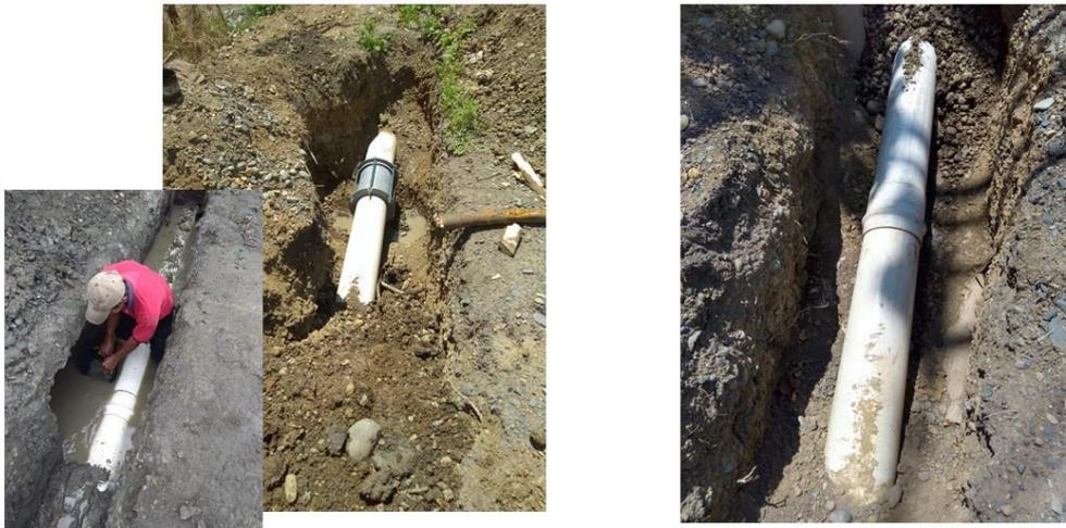
**DAÑO OCASIONADO POR TERCEROS AL INSTALAR UNA ALCANTARILLA EN
