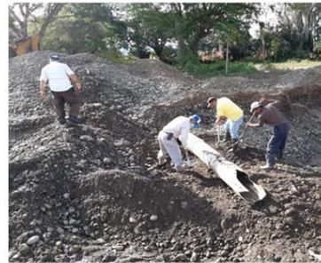
DAÑO EN LOS EMPAQUES DE UNIÓN DESSER DE 14" A LA SALIDA DEL CUARTO DE VÁLVULA
