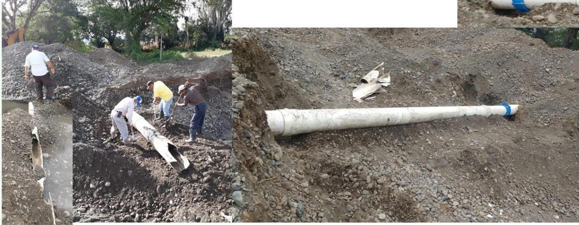
**REPARACION TUBERÍA DE 10 PULGADAS OCASIONADO POR MAL EMPALME
