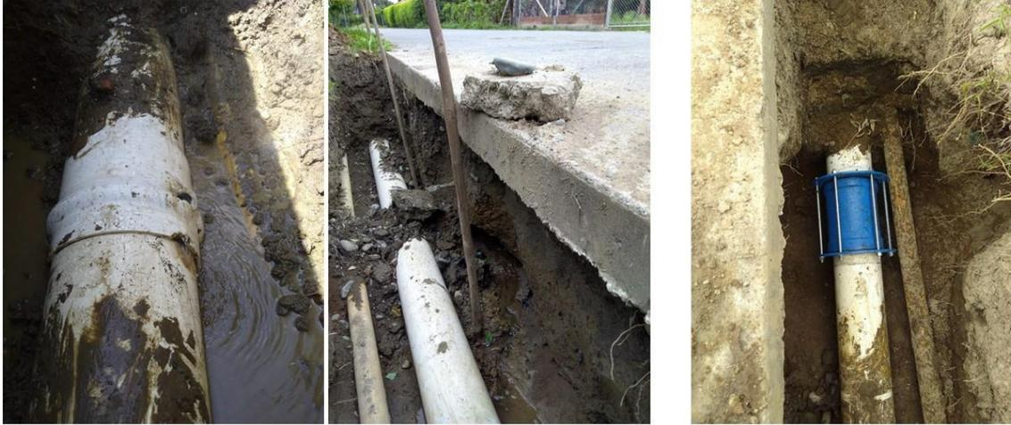
**DAÑO OCASIONADO POR MAL EMPLAME EN LA TUBERÍA DE 8 " EN LA EXTENSIÓN DE LA RED
