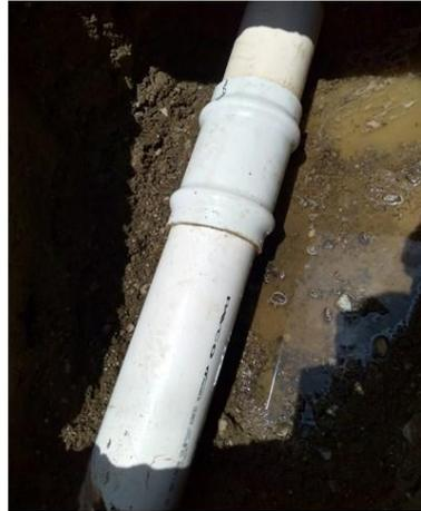
**DAÑO EN TUBERÍA DE 4" OCASIONADO POR APLASTAMIENTO DE
