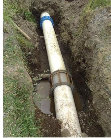
**DAÑO OCASIONADO EN TUBERÍA DE 14” POR MAQUINARIA DURANTE LA ADECUACIÓN DE TERRENO PARA
